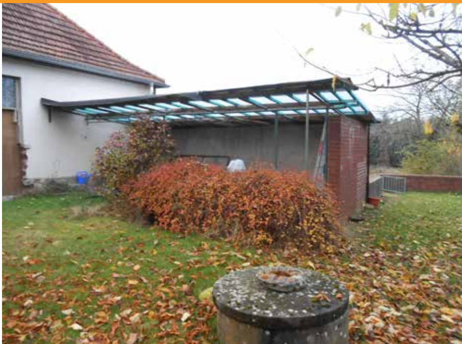
Der Außenzwinger: Das neue Dach ist drauf
